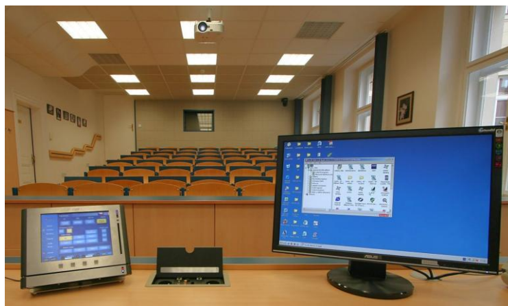
Ovládací bezdrátový dotykový LCD panel, konektorové pole, příhledový monitor
